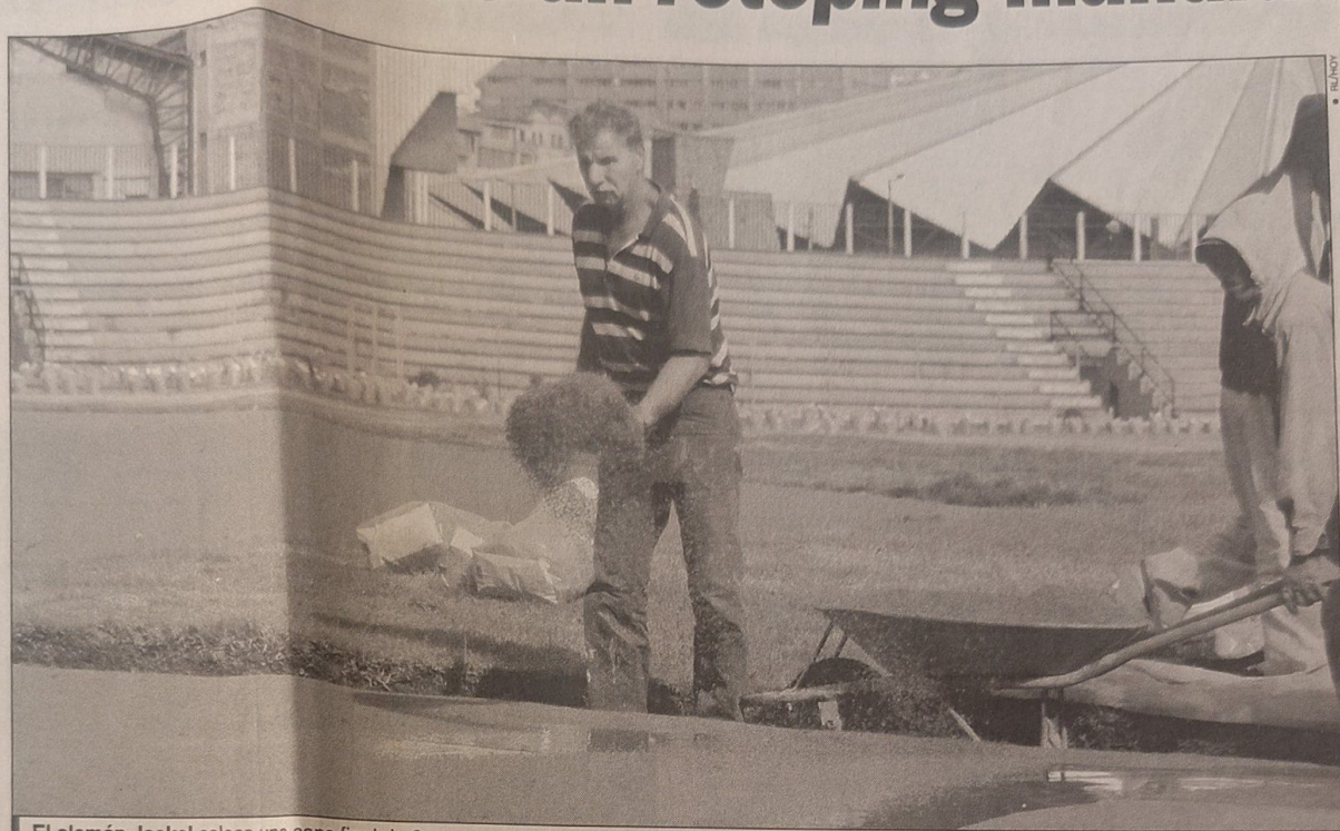
El alemán Jaekel coloca una capa final de 3 mm que tiene como base poliuretano y gránulos EPDM de características autonivelantes
