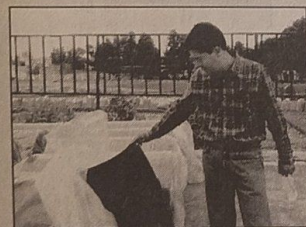
Pista de entrenamiento: se usan rollos de 10 mm prefabricados sobre una base de asfalto
